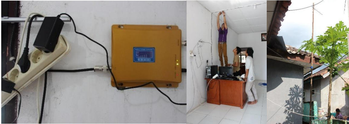
(kiri-kanan): instalasi penguat signal internet, perbaikan jaringan LAN, Antenna penguat signal internet (wifi).
