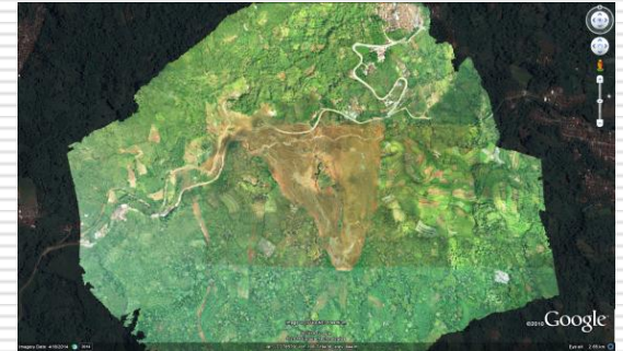
Pemotretan Longsor di Banjarnegara
